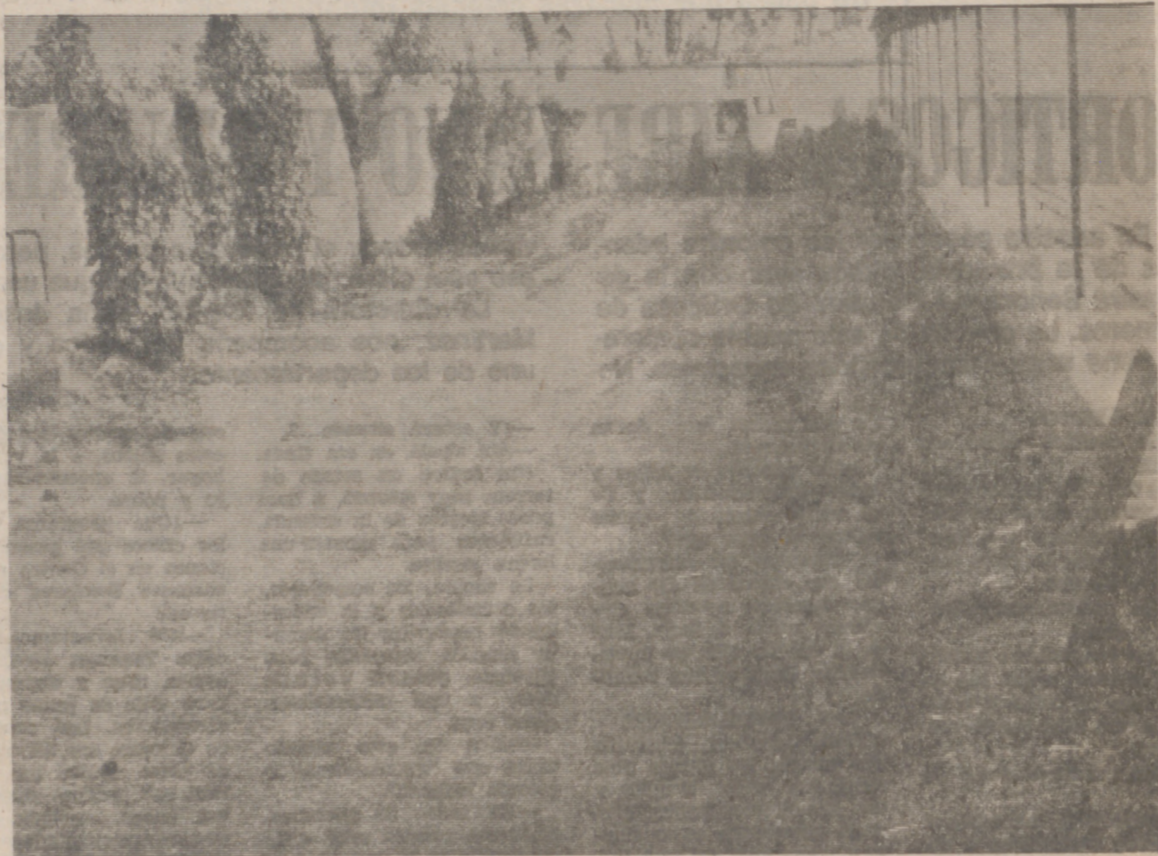
Las obras de las instalaciones del campo de Las Gaunas están en marcha. (Foto HERCE)
