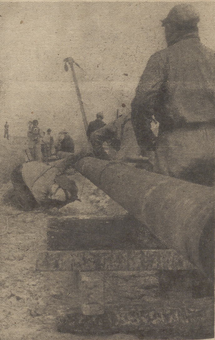
Invitados por la Embajada de los Estados Unidos, un grupo de periodistas visitaron las obras del oleoducto que se está construyendo desde Rota a diversos puntos de España, a través de unos setecientos kilómetros de territorio español. En la fotografía, un aspecto de las obras que allí se realizan.
