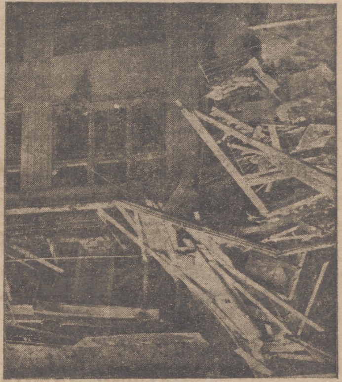
Destrozos que causaron las bombas inglesas en la «Casa de los Médicos» de Berlín
