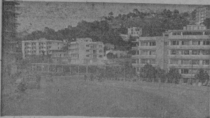
LA AMPLIACION DE LA CARRETERA DE CALA MAYOR: UN EJEMPLO A SEGUIR, SI NO EN CUANTO A LA BREVEDAD DE LAS OBRAS, SI AL MENOS EN EL RESULTADO.
