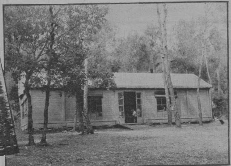
Larasa.—Una de las tiendas desmontables instalada en la fuente de Llimac
