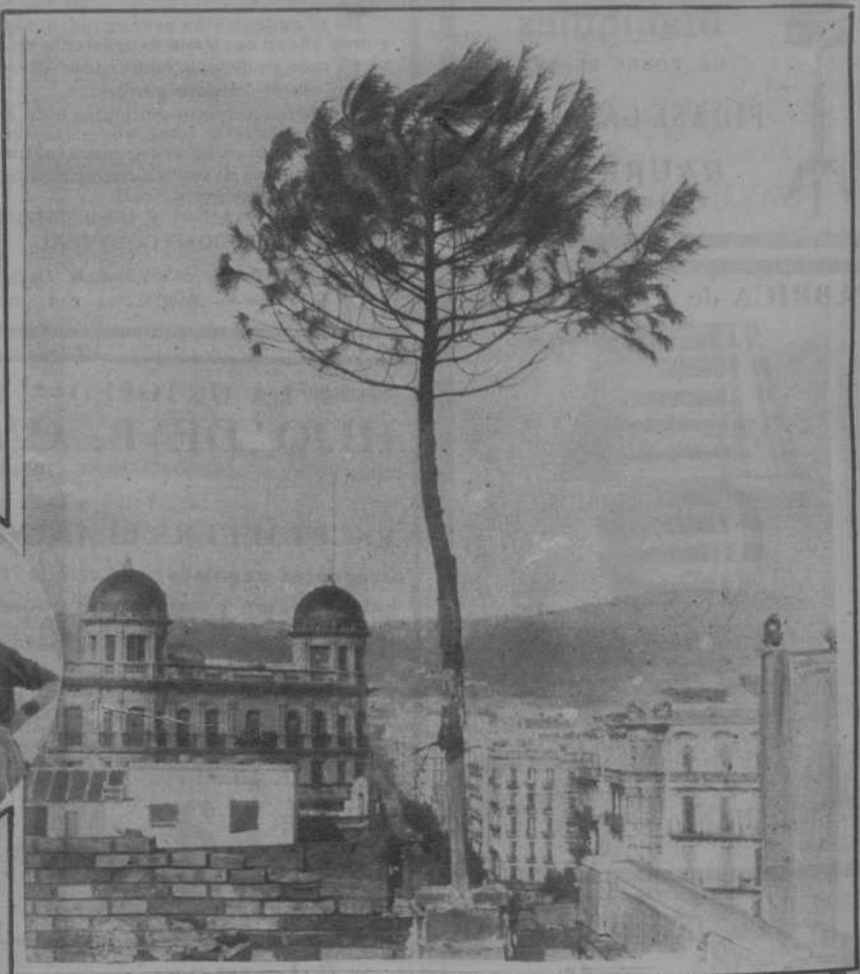
Un capricho. Hasta ahora, al cubrir aguas en las obras en construcción, era costumbre colocar una bandera en lo más alto del edificio. Ahora, la costumbre la ha roto el constructor de una casa, en la calle de Entenza, esquina a Diputación, de nuestra ciudad que, conforme se ve en la fotografía, ha «arbolado» un pino. Y creemos que nunca estuvo tan bien empleado el verbo «arbolarse».
