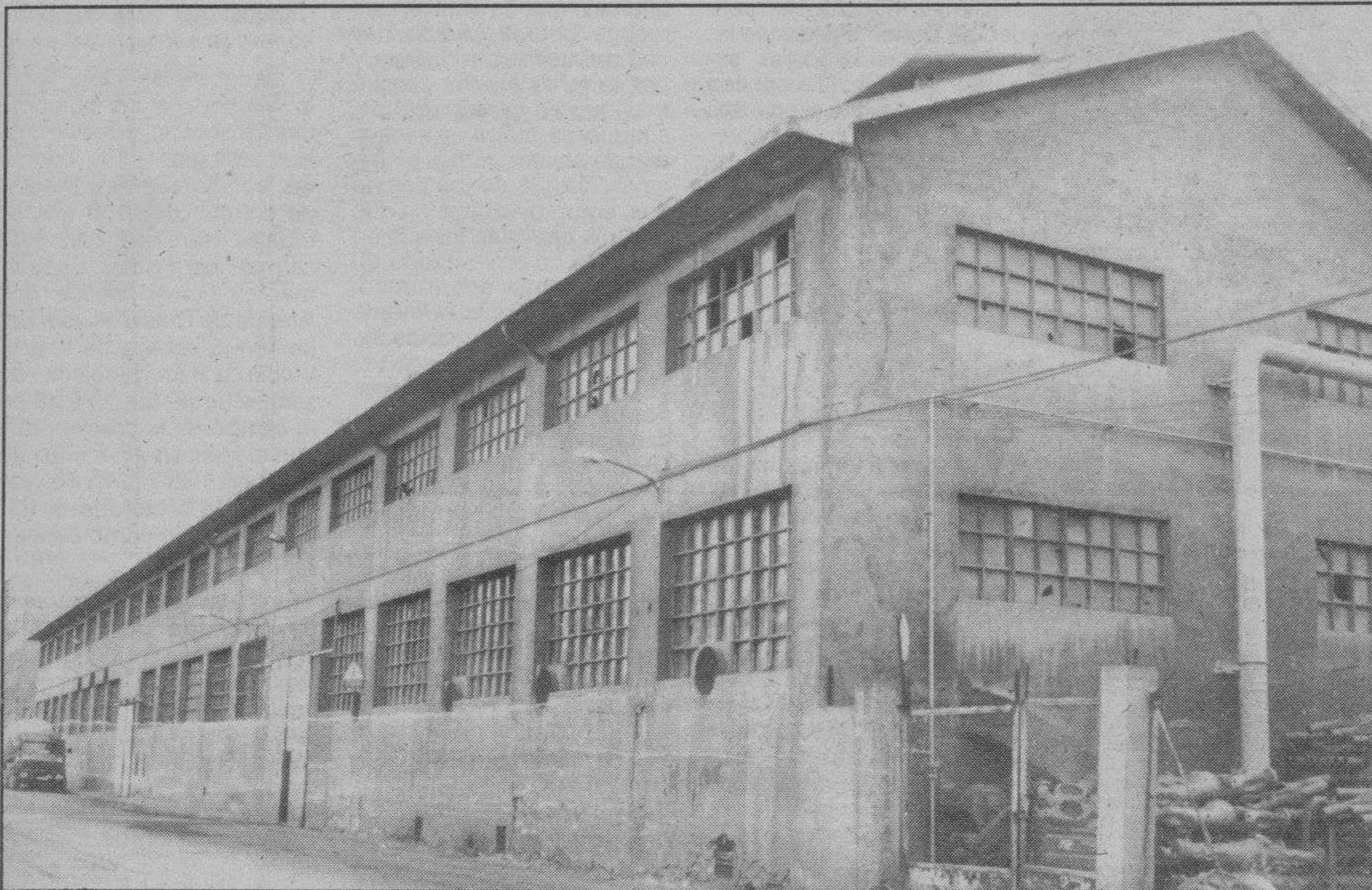
Concluyeron ya los trabajos de instalación de filtros anticontaminantes en Fundiacero. Los representantes municipales comprobarán esta tarde la efectividad de las obras realizadas. Foto Truchuelo.
