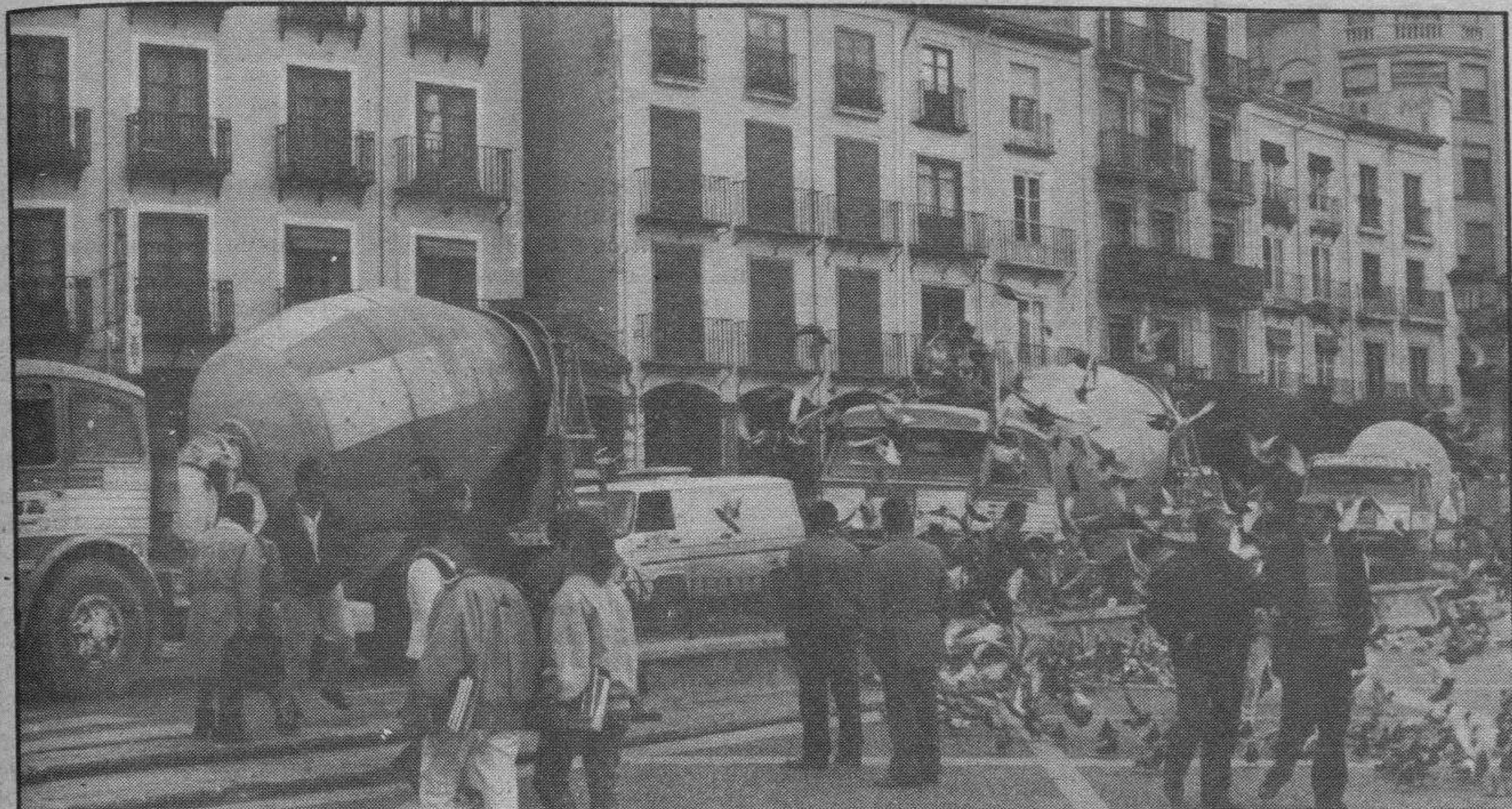
Tras movilizaciones de pasadas semanas el conflicto de la planta de Hormigones «Abadesa» presenta una nueva vertiente. El Ayuntamiento ha ordenado la demolición de las instalaciones de esta empresa.
