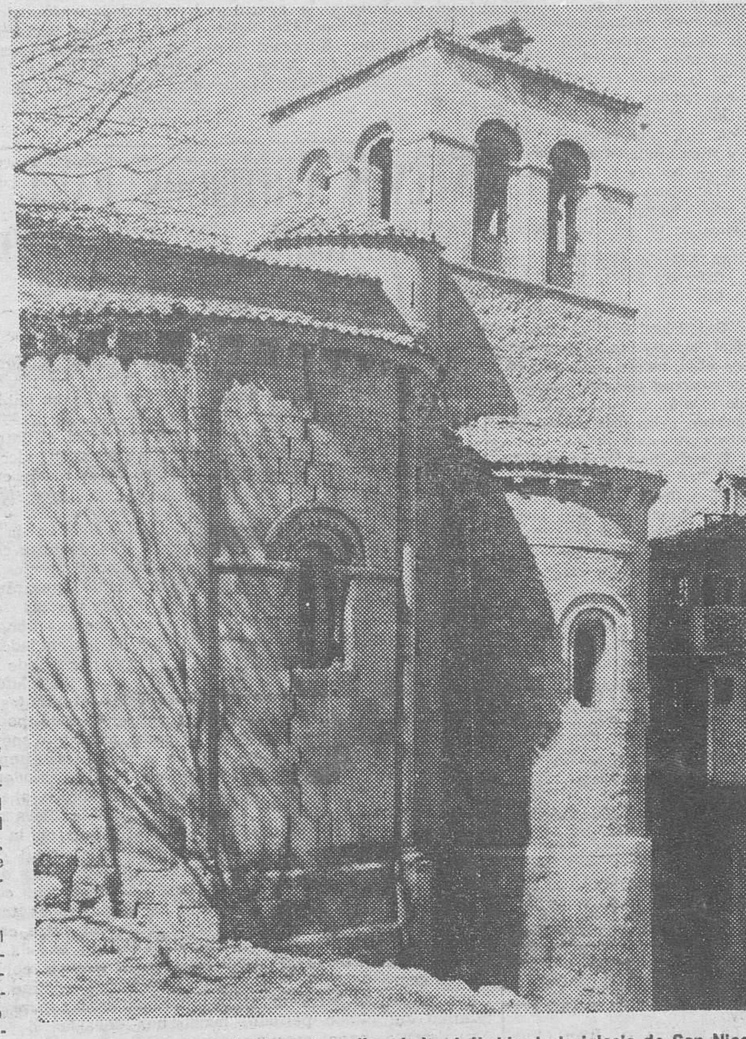
Una peligrosa grieta atraviesa de arriba abajo el ábside de la iglesia de San Nicolás, una destacada muestra del románico segoviano. — (Foto EFE-FIEL).
