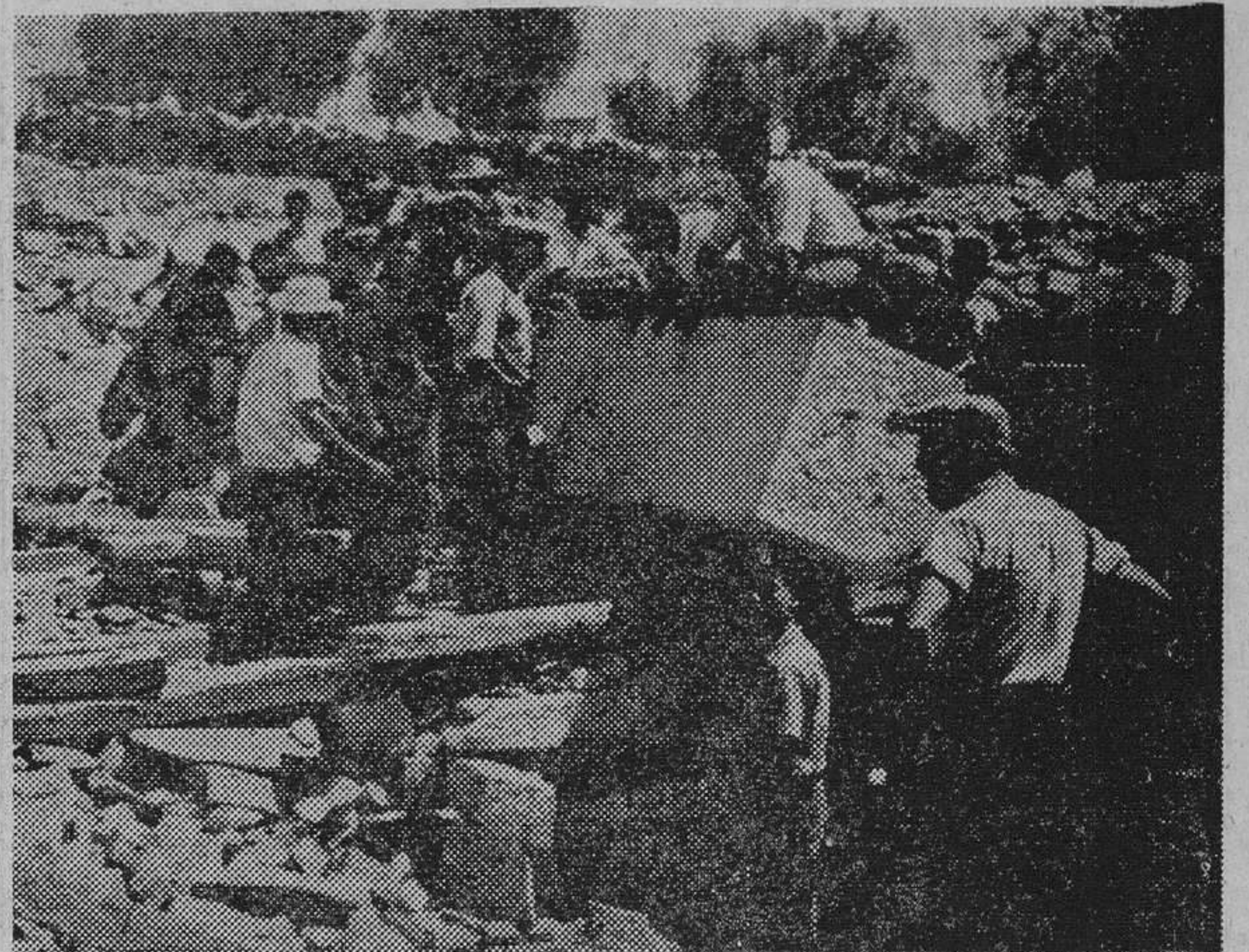
Catorce horas duró cada una de las operaciones de carga y descarga de esta gigantesca pilastra de granito de 9,11 metros de longitud y 16 toneladas de peso, una de las dos que figurarán en el monumento a los héroes del Alcázar. Desde el siglo XVI es la primera vez que se obtienen en España unas columnas de estas dimensiones en una sola pieza. En la foto, la pilastra es cargada en un remolque en las canteras de la Serena (Badajoz) para su traslado a Madrid.
