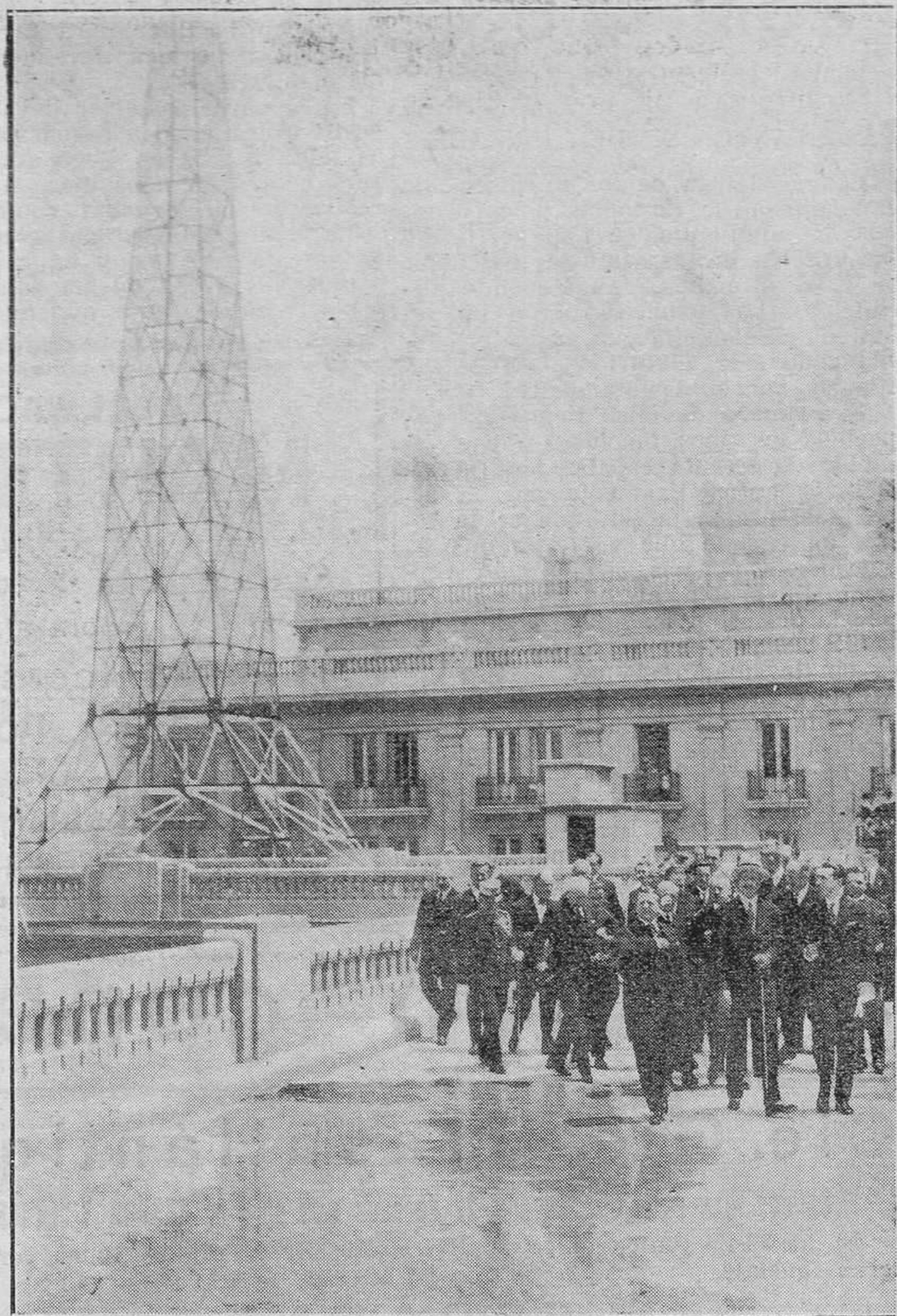
MADRID.-El Rey viendo las instalaciones de la terraza del edificio de la nueva estación emisora de radiotelefonía. [Foto Vidal]
