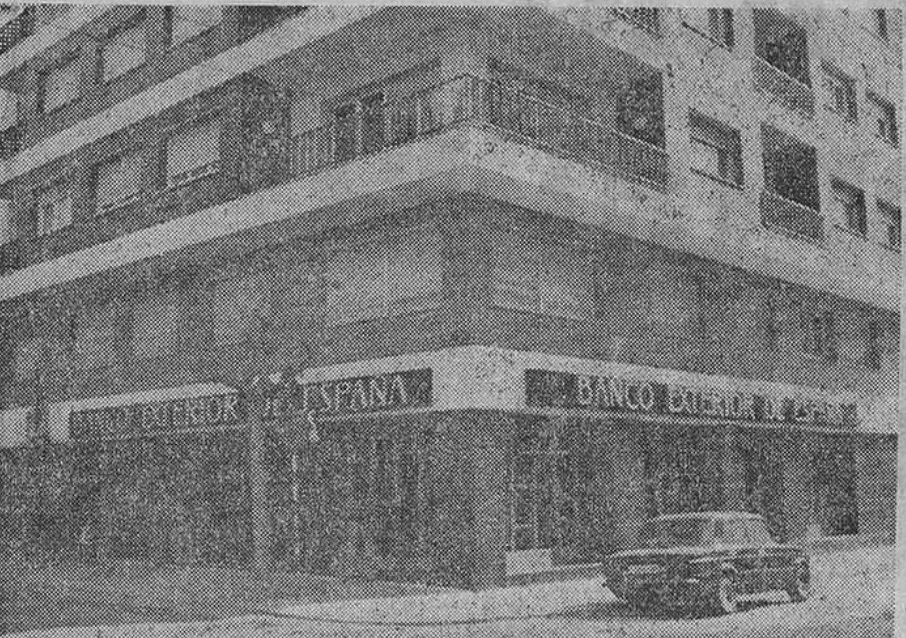
Edificio de la nueva sucursal
