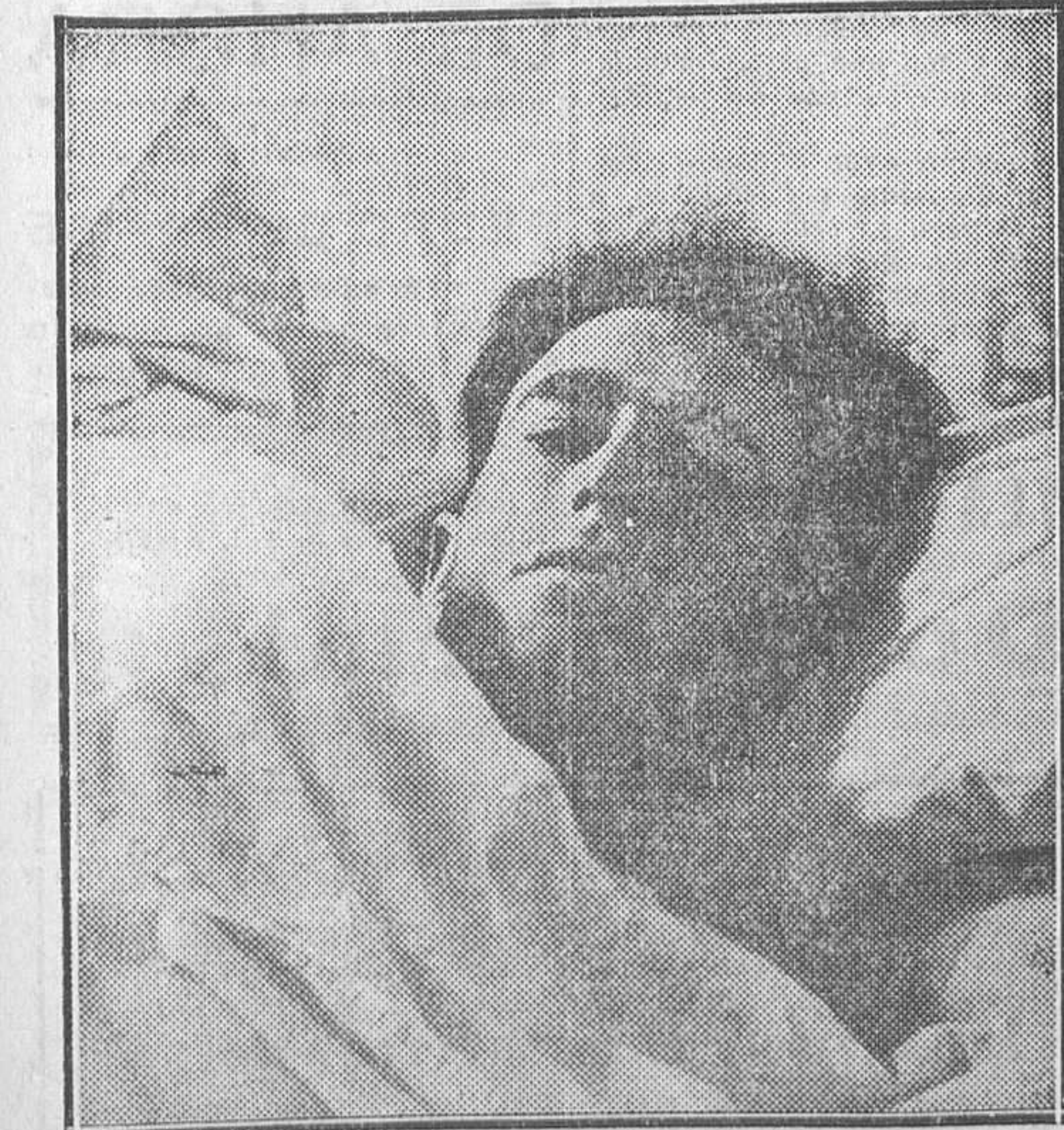
El obrero Emilio González, gravemente herido en el derrumbamiento del andamio de la casa en construcción de la calle de Oquendo
