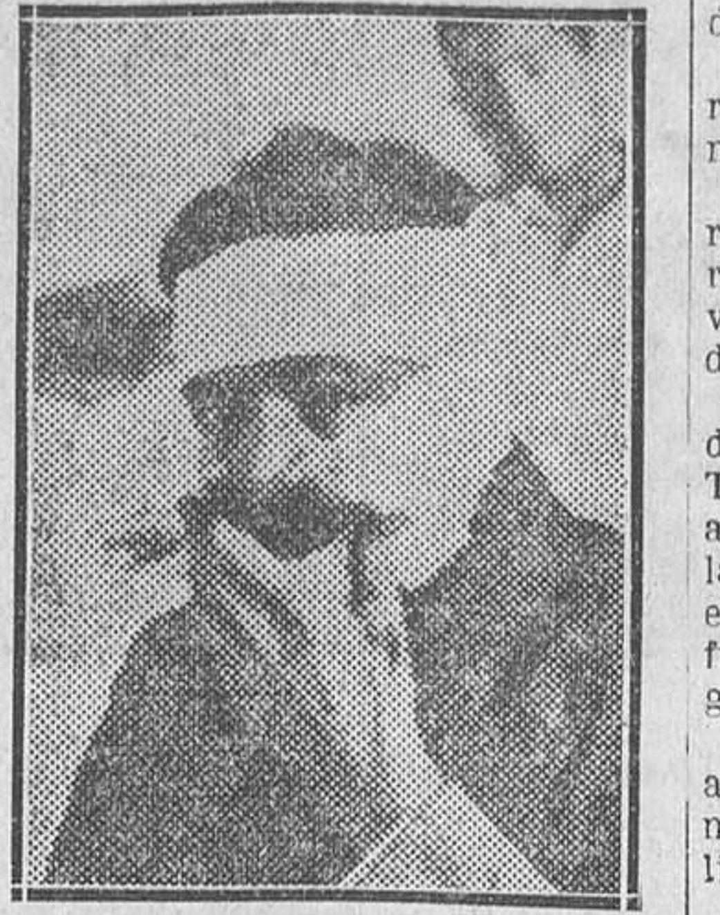
El obrero Teodoro del Castillo, gravemente herido en el derrumbamiento del andamio de la casa en construcción de la calle de Oquendo
