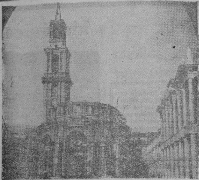
Un aspecto de la Universidad Laboral de Gijón, durante las obras ya terminadas. Hay Universidades Laborales en numerosas provincias, todas construidas "ad hoc", suntuosamente.
