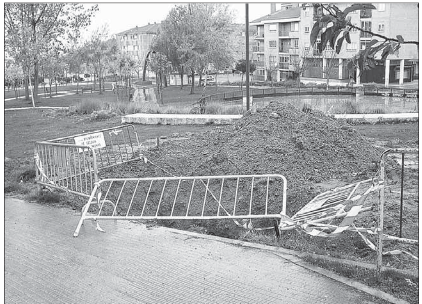
Una de las zanjas abiertas para localizar la avería se sitúa muy cerca del Parque del Reloj./M.G.
