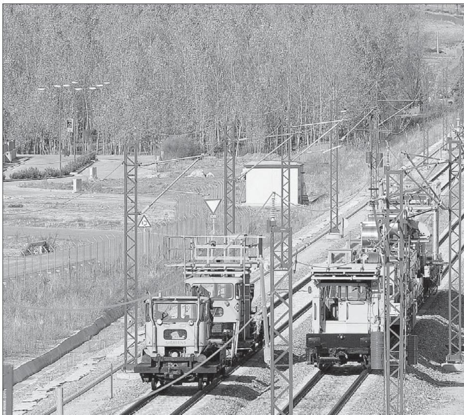
Varias máquinas instalan el tendido eléctrico en las catenarias que se han colocado a lo largo de los más de cien kilómetros del recorrido de
