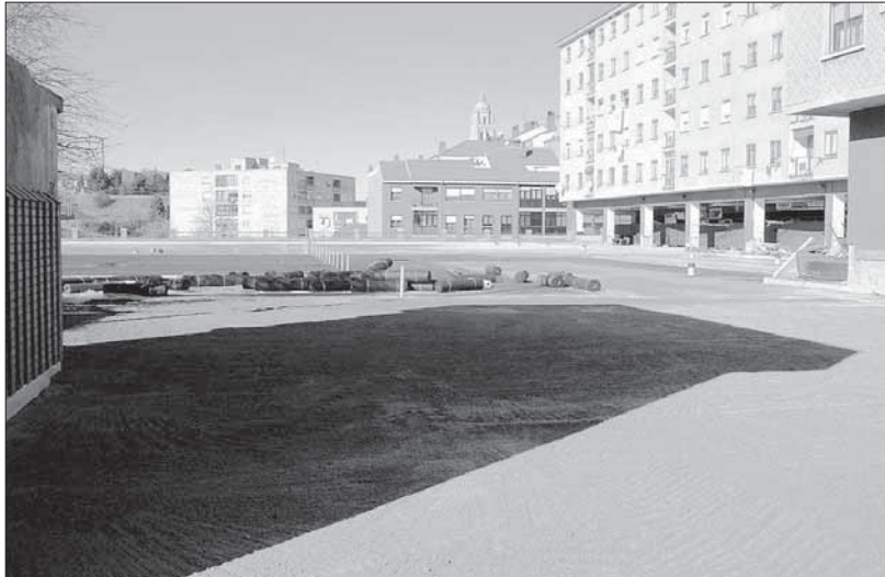
El arreglo de la campa ha retrasado el final de las obras de la estación de autobuses
