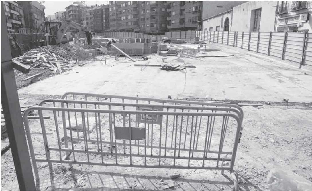
Los operarios de "Collosa-Pygsur" han culminado en los últimos días la ejecución de todos los forjados del aparcamiento
