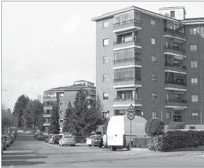
La zona de Los Castillos, en la Albuera, ha sido incluida en la nueva fase de obras
