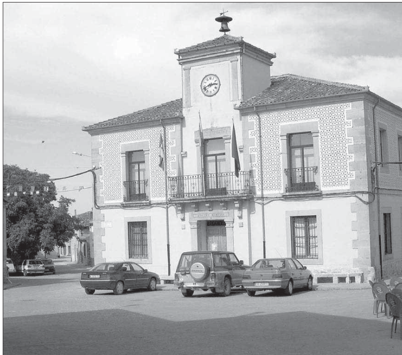
Vista del Ayuntamiento de la localidad de Sebúlcór
