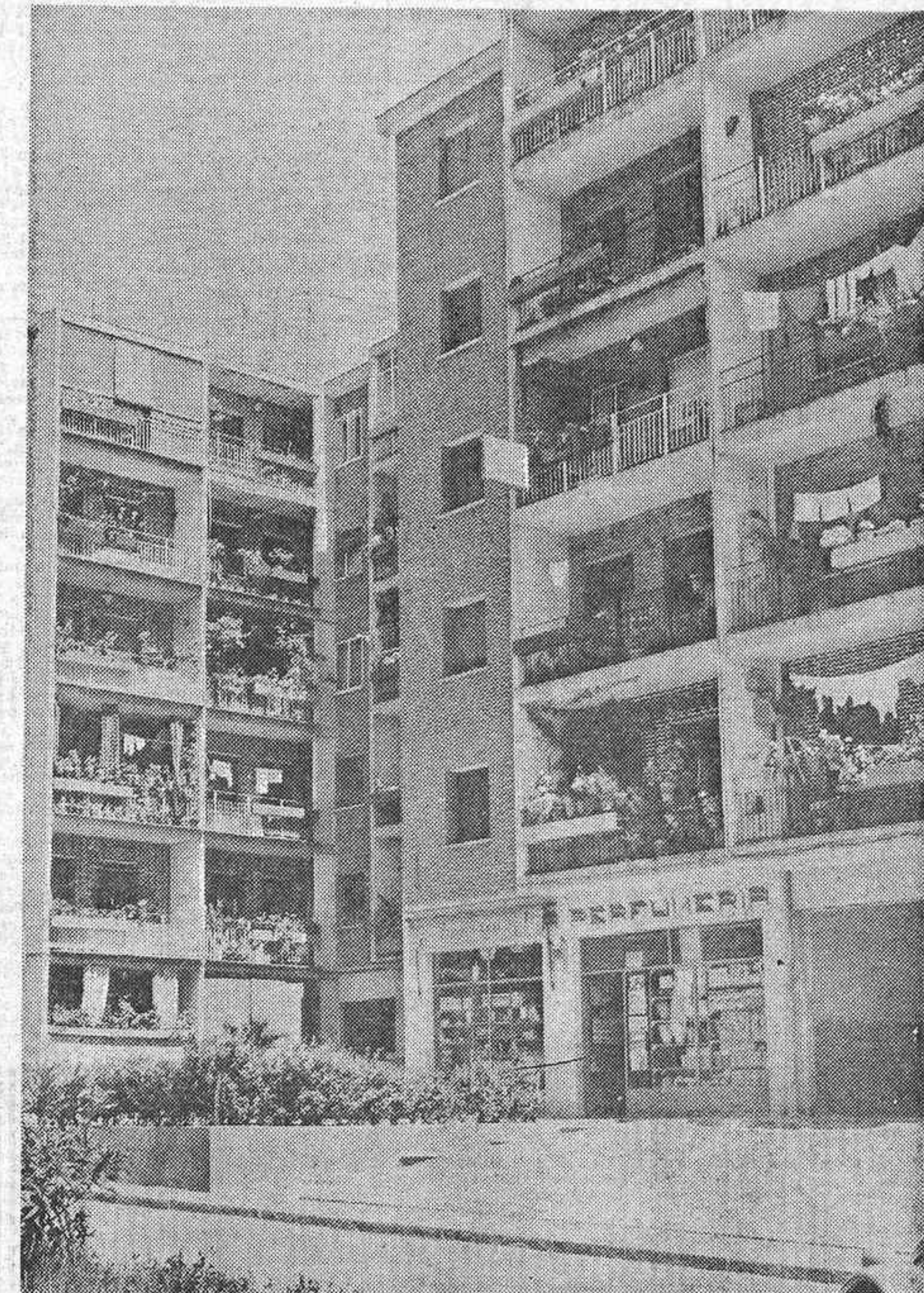
A veces el paso de unas condiciones precarias a un alojamiento con unas condiciones adecuadas no supone un estado de salubridad. (Foto Torremocha.)
