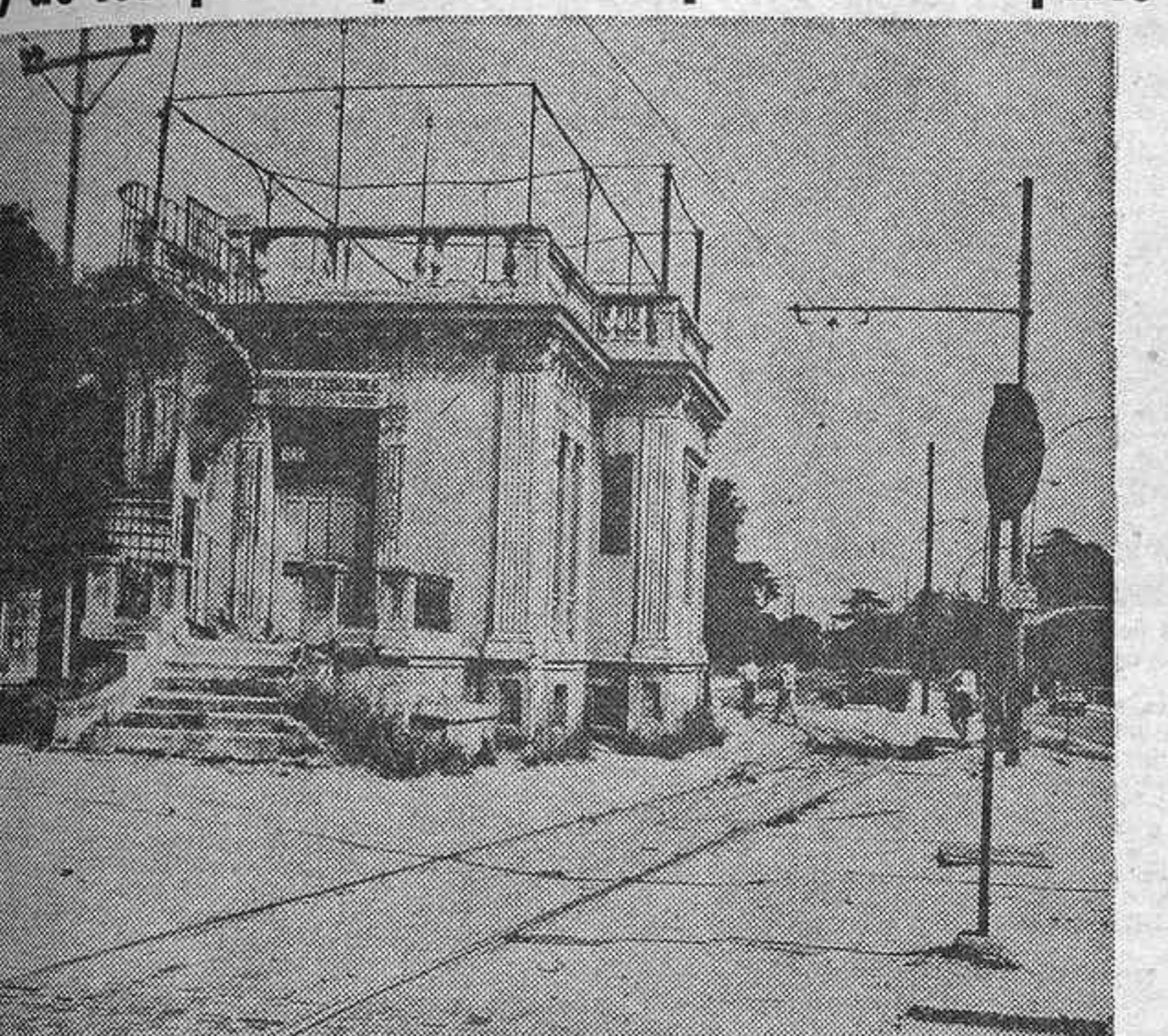
También se procede en estos momentos a los trabajos de ornamentación y alumbrado y a otras tareas de ordenación del sector. (Foto Torremocha.)
