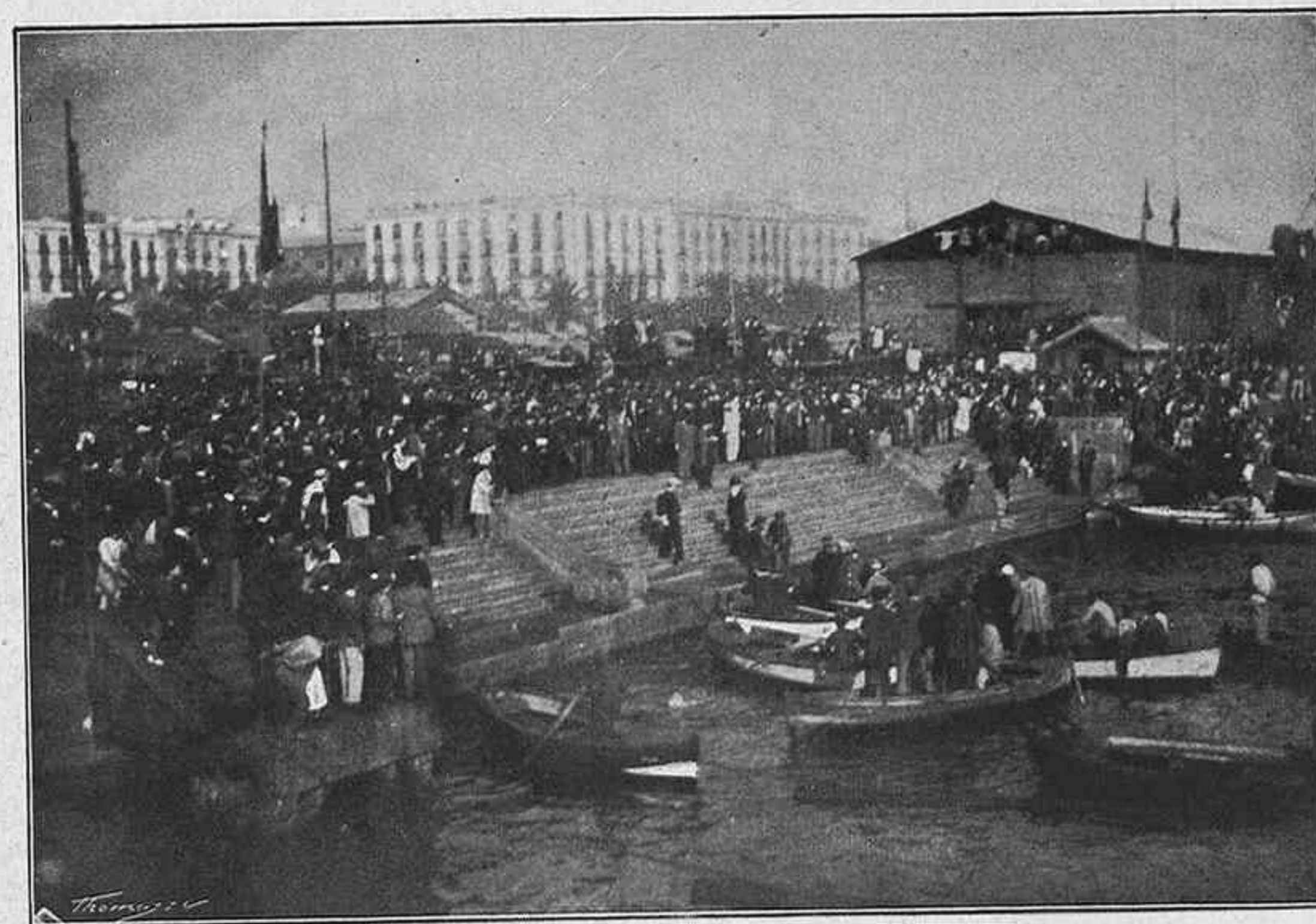
LLEGADA DEL GENERAL WEYLER Á BARCELONA DESEMBARQUE EN LAS ESCALERAS DEL MUELLE DE LA PAZ EN BARCELONA
