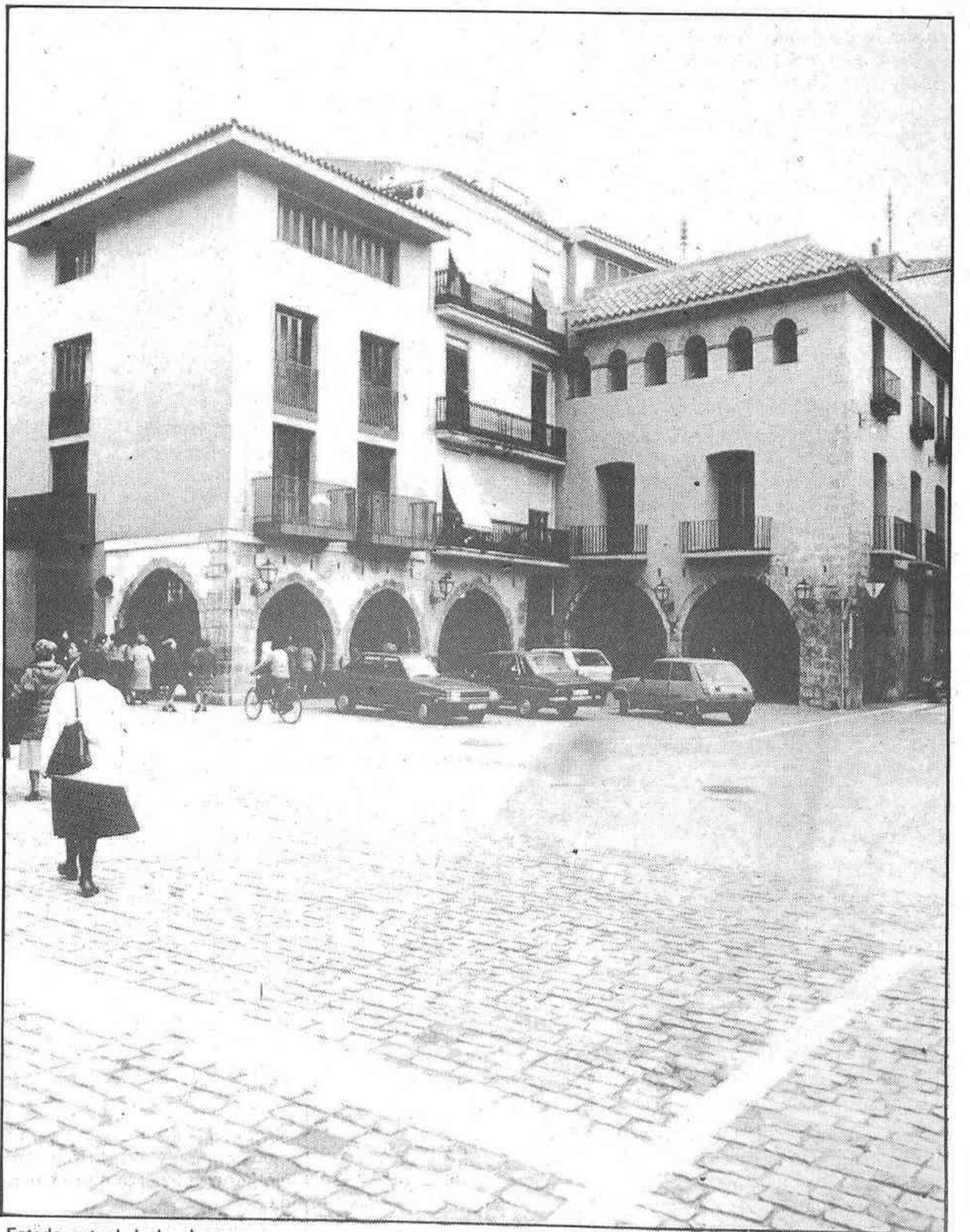
Estado actual de la plaza
