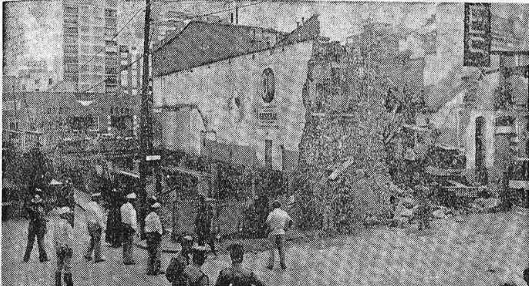
Vista general de la casa hundida, mientras se procede al desescombro con una máquina retroexcavadora. — (Foto HEREDIO)
