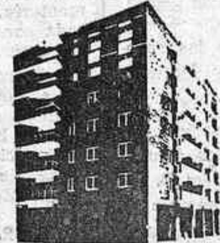
Casa n.º 32-36 calle La Mina. Compuesto de 5 locales comerciales y 63 viviendas. BADALONA
