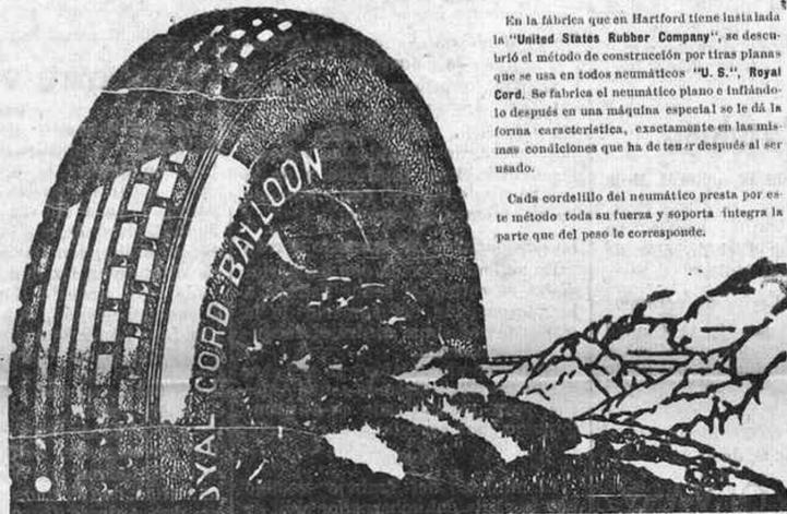
En la fábrica que en Hartford tiene instalada la "United States Rubber Company", se descubrió el método de construcción por tiras planas que se usa en todos neumáticos "U. S.", Royal Cord. Se fabrica el neumático plano e inflándolo después en una máquina especial se le da la forma característica, exactamente en las mismas condiciones que ha de tener después al ser usado.
