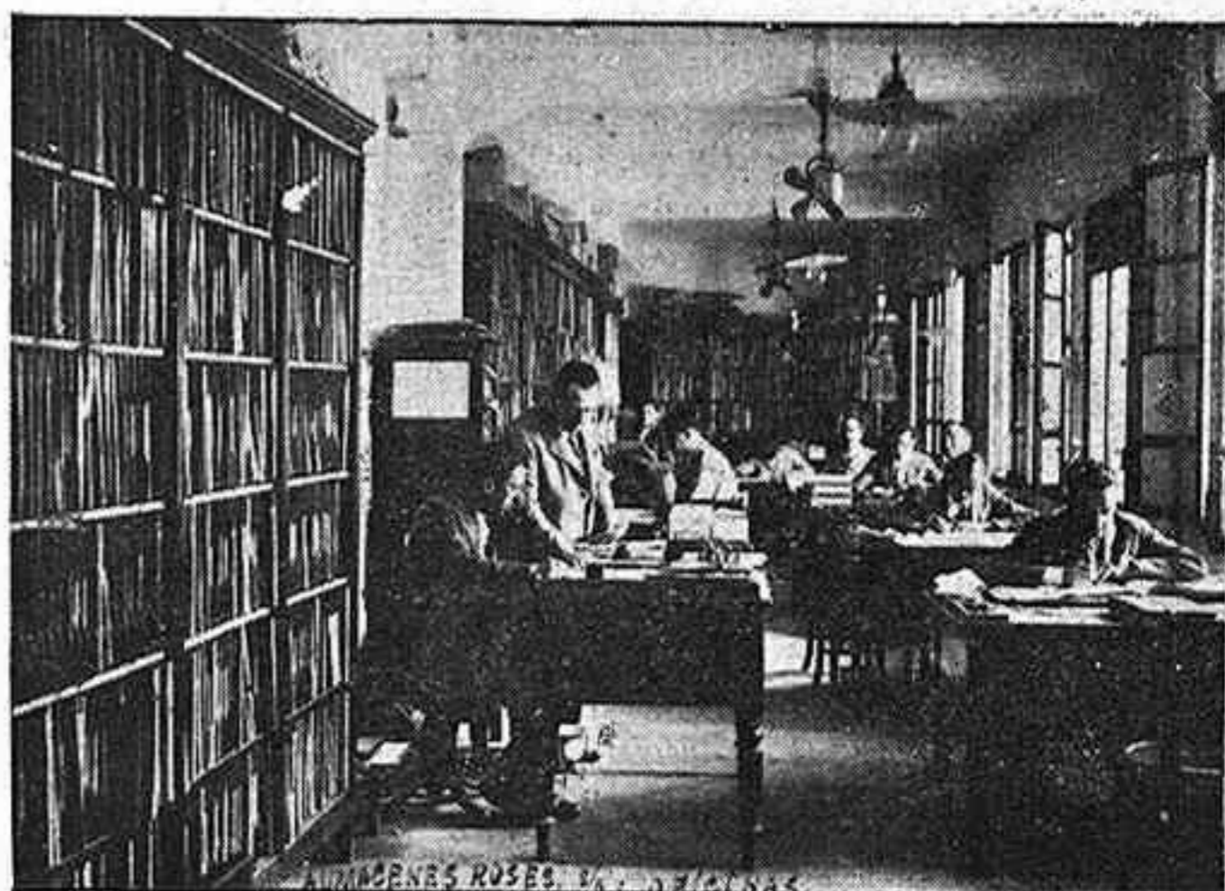
Vista parcial de las oficinas.
