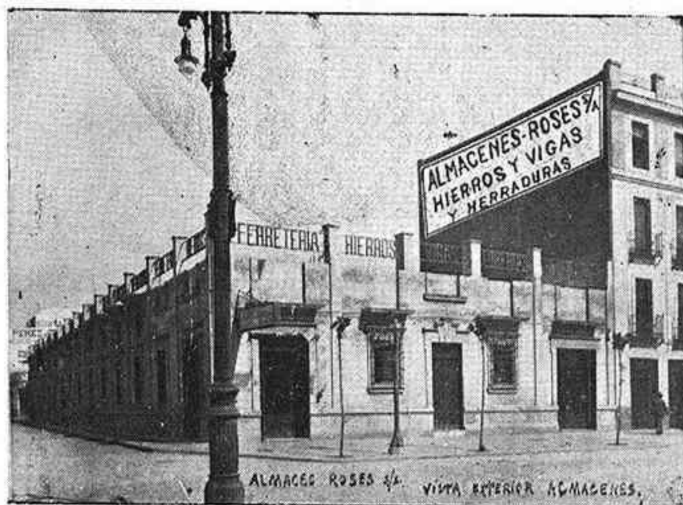
Vista general del edificio
