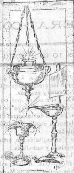
Con el curso de los años, y según las necesidades de cada época, inventáronse sucesivamente la lámpara de Argán, llamada comúnmente «quinquet», la lámpara neumática, en la que se puede propagar la luz en todas direcciones; la lámpara ignífera, que se enciende por sí misma, y la lámpara de seguridad, para uso de las minas, sin que haya peligro de que se inflamen los gases que se desprenden de ellas.
