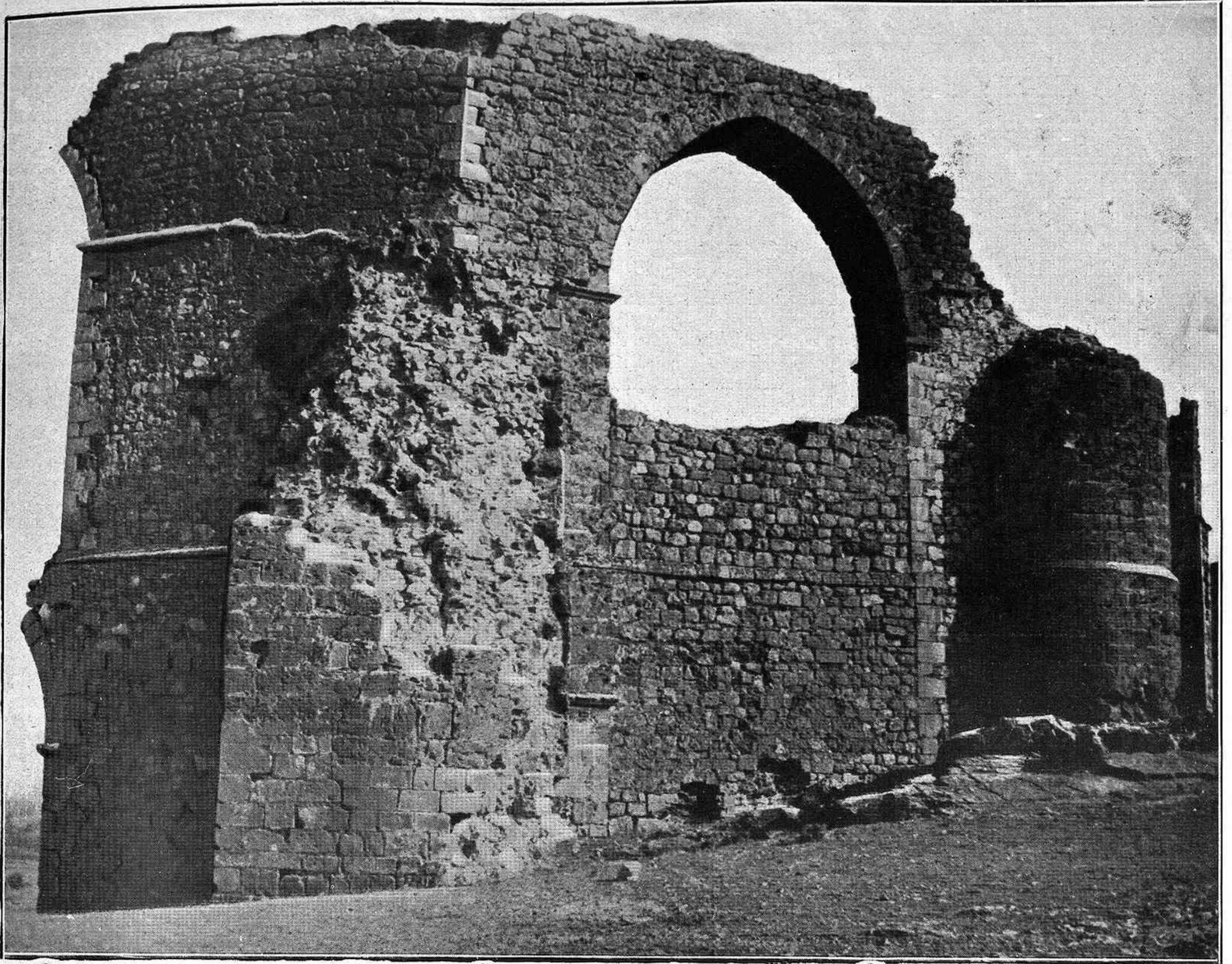
Alcaraz. — «Los Arcos». Ruinas del acueducto
