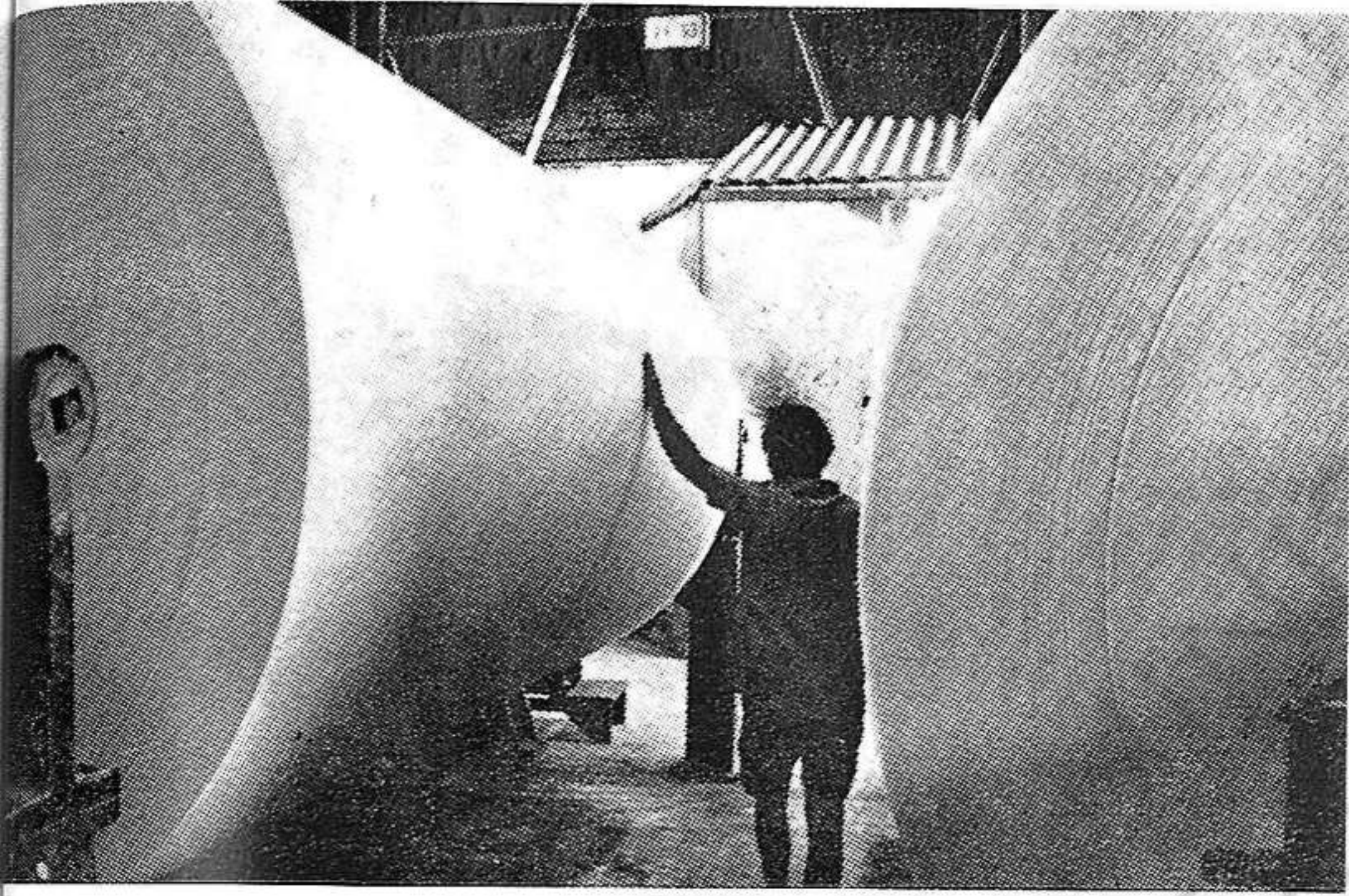
Un rollo de papel de 10 toneladas sale cada 40 minutos de la mayor máquina para papel periódico de Francia. La máquina tiene 97 m de largo; la cinta de papel circula a la velocidad de 42 km-hora.
