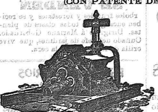
Nuevo aparato perfeccionado para extraer agua, aprovechando los arcadnces hasta la última gota del liquido, y con el más pequeño esfuerzo de las caballerías, por la disposición de la artesa ypor la suavidad de los rozamientos montados sobre armadura de cilindros.
