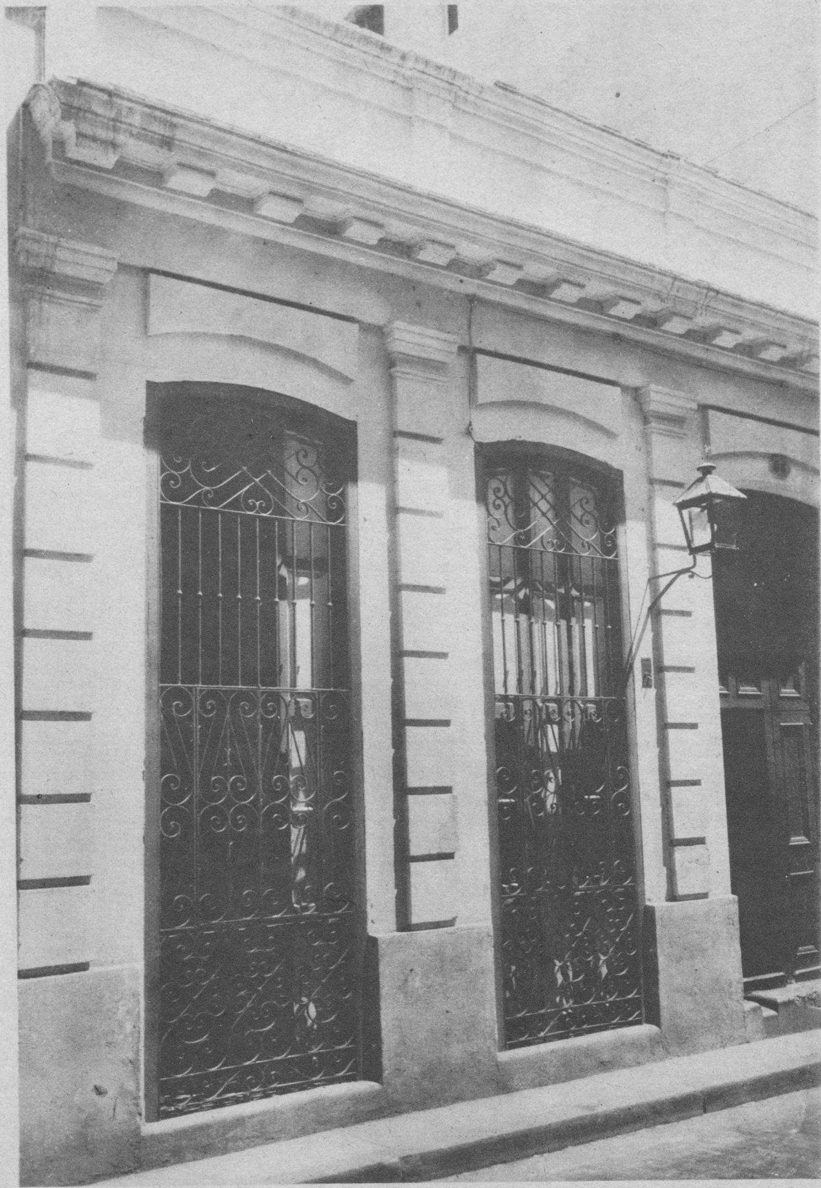
Vista del antiguo edificio
