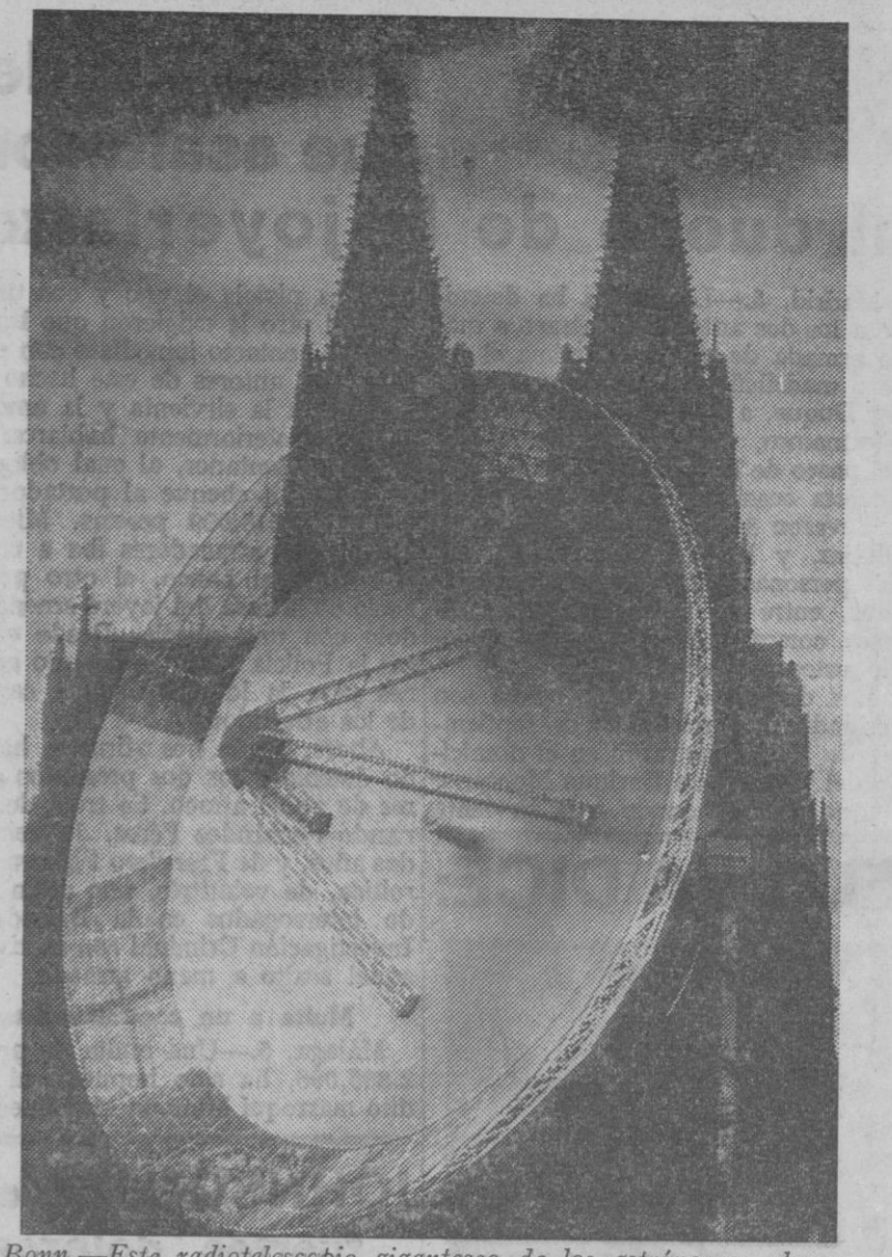
Bonn.—Este radiotelescopio gigantesco de los astrónomos alemanes servirá más alto que el coro de la catedral de Colonia, como lo demuestra la foto de la maqueta, exacta a escala. El radiotelescopio más grande del mundo tendrá por objeto buscar señales procedentes del universo. El espejo tiene un diámetro de cien metros.
