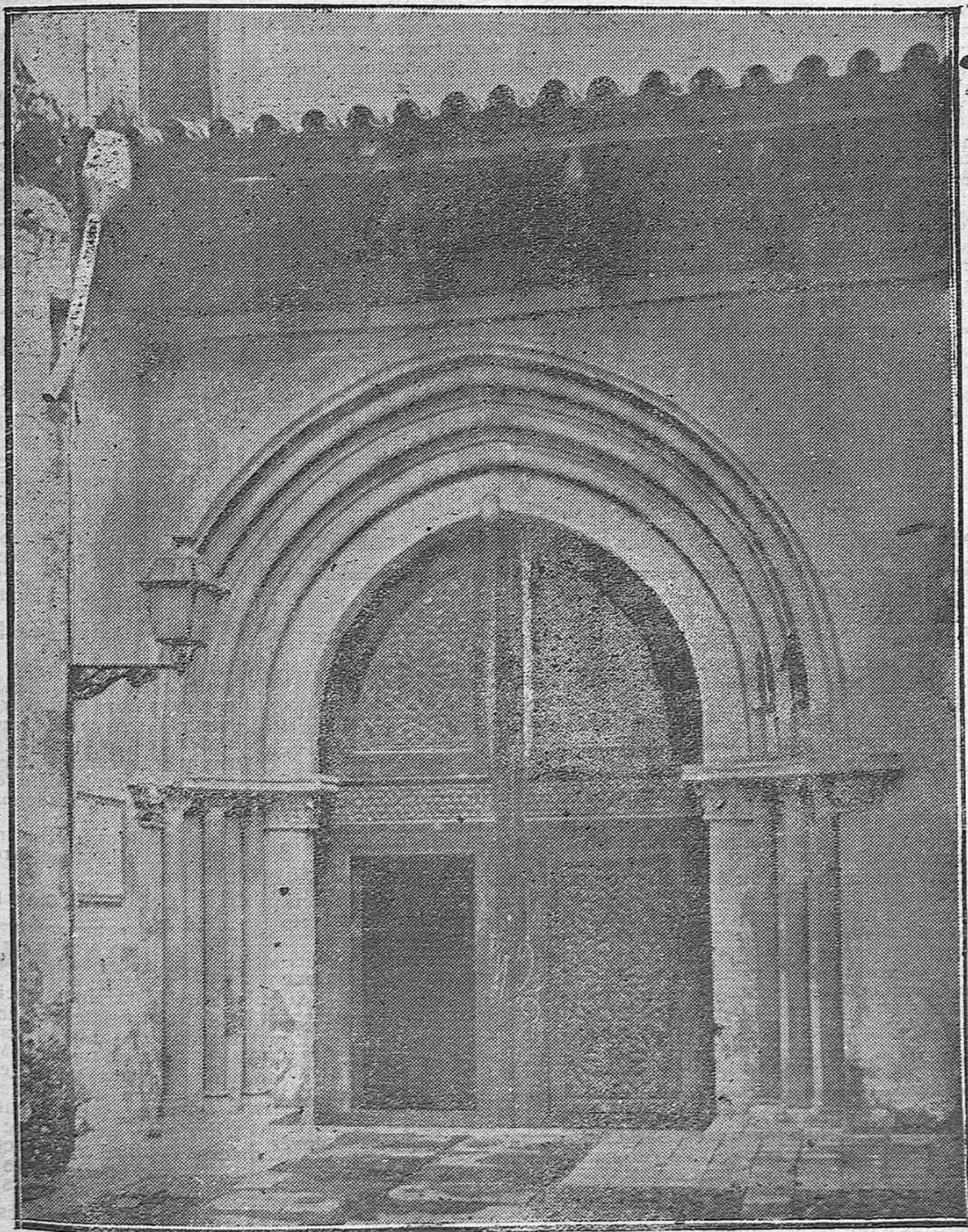
PORTADA LATERAL DE LA REAL IGLESIA DE SAN PABLO, QUE ACUSA LA ARQUITECTURA RELIGIOSA CORDOBESA DE LA RECONQUISTA, EN LA QUE SE AUNAN EN MARAVILLOSO CONJUNTO, LOS CAPITELLOS DEL CALIFATO CON LA MAGNIFICA PUERTA DE MADERA DE TRACERIA MUDEJAR.
