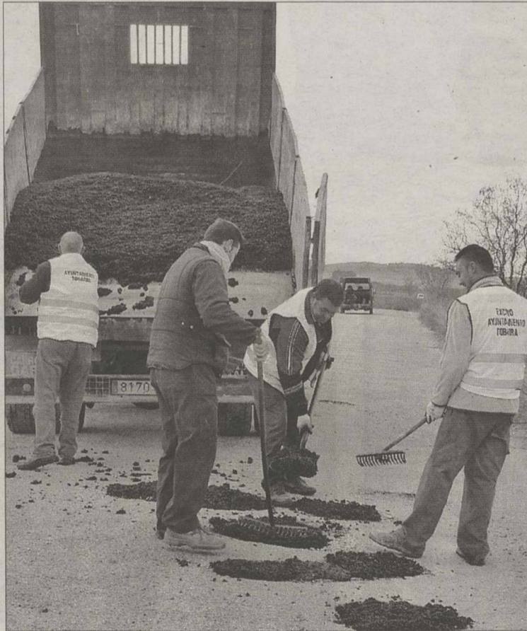
Operarios municipales parchean el camino de la zona de Polope. / G. G.
