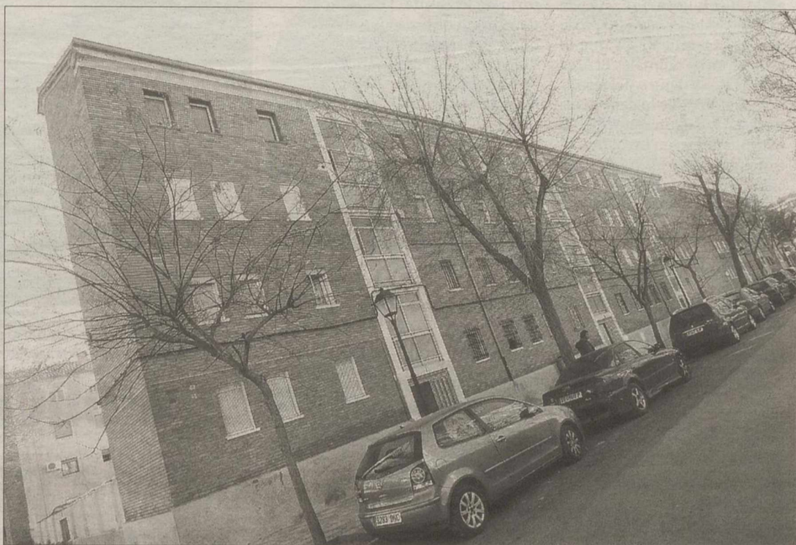
Viviendas de las conocidas como 'grilleras' en el área de rehabilitación de Santa Teresa. / R.S.
