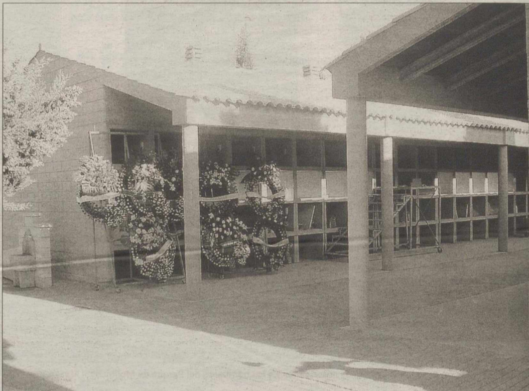
Imagen del cementerio de la localidad con los nuevos nichos construidos. / A.VICO
