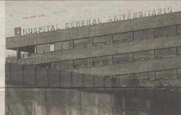
Imagen de la fachada del Complejo Hospitalario de Albacete.
