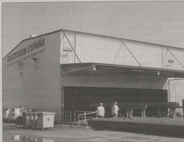
La empresa Socotherm ha remitido un proyecto para ampliar instalaciones. / A.R.
