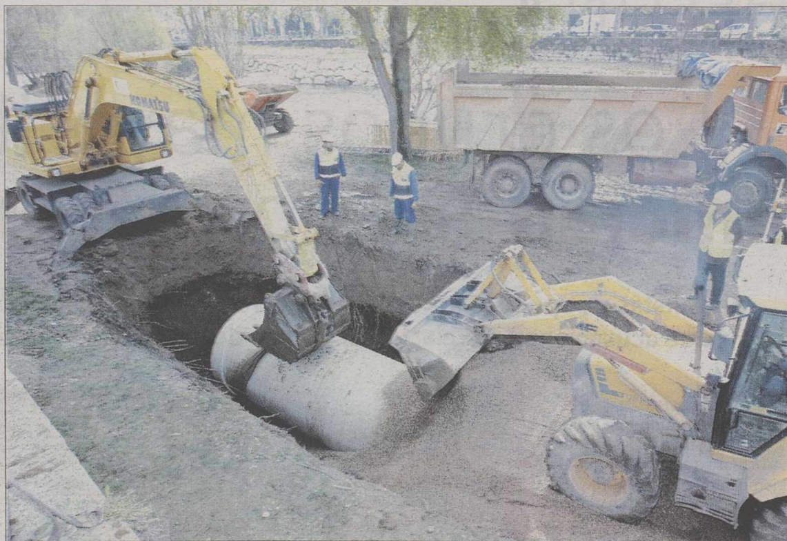
Obras de construcción de un nuevo colector de aguas pluviales similar al que se quiere hacer en Villamalea. / L.L.A.
