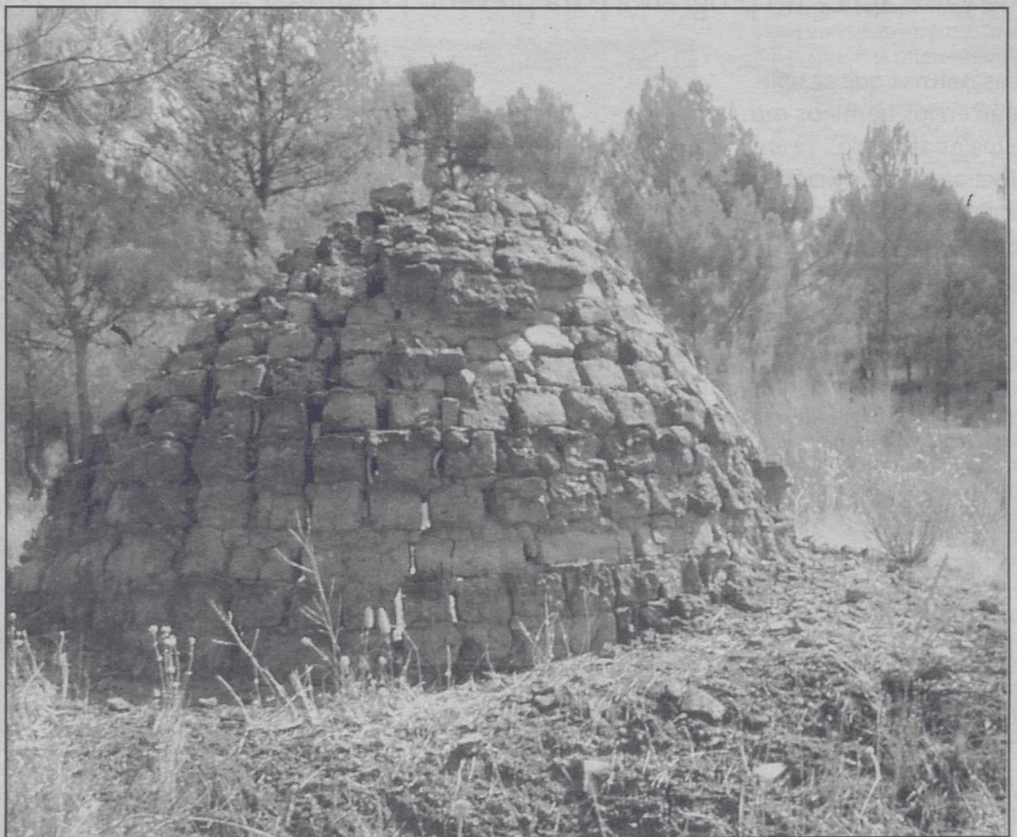
La peguera es una construcción de ladrillo (refractario) circular o ligeramente ovalada. / ÁNGEL ÑACLE
