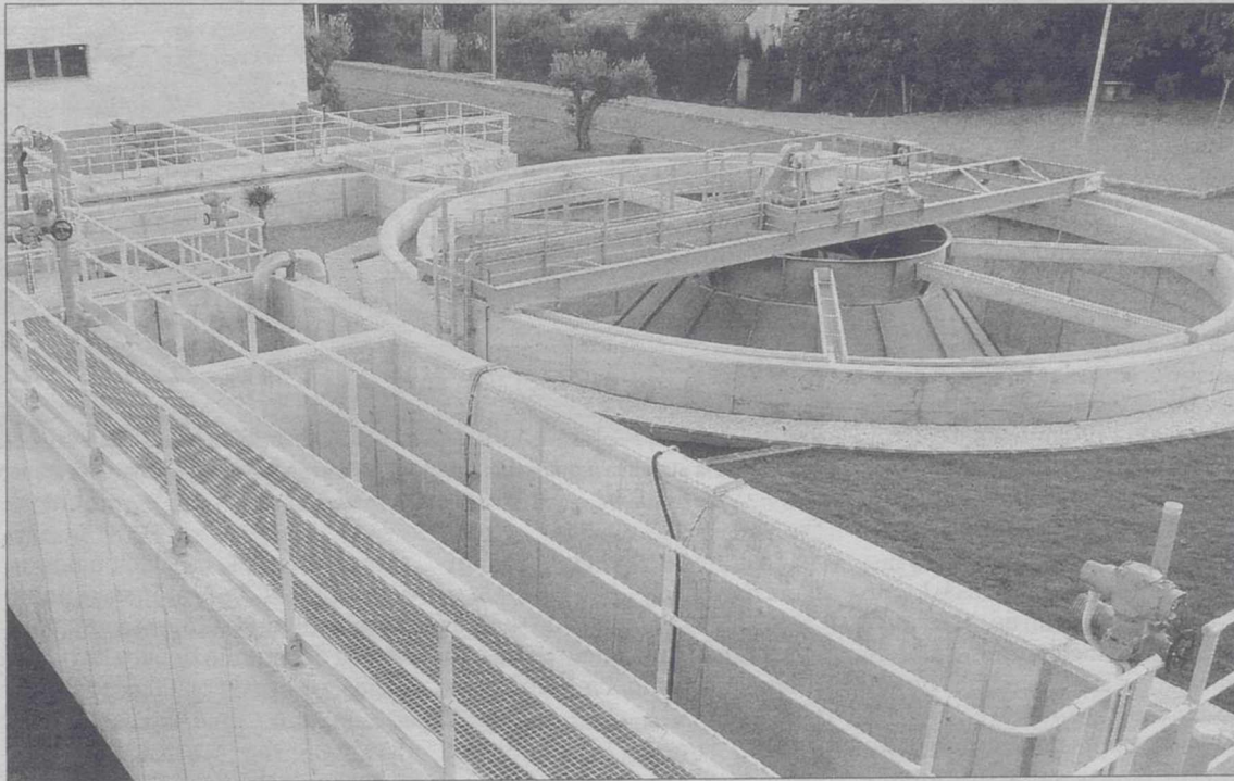
Instalaciones de la nueva potabilizadora de Hellín. / ÁNGEL ROMERO
