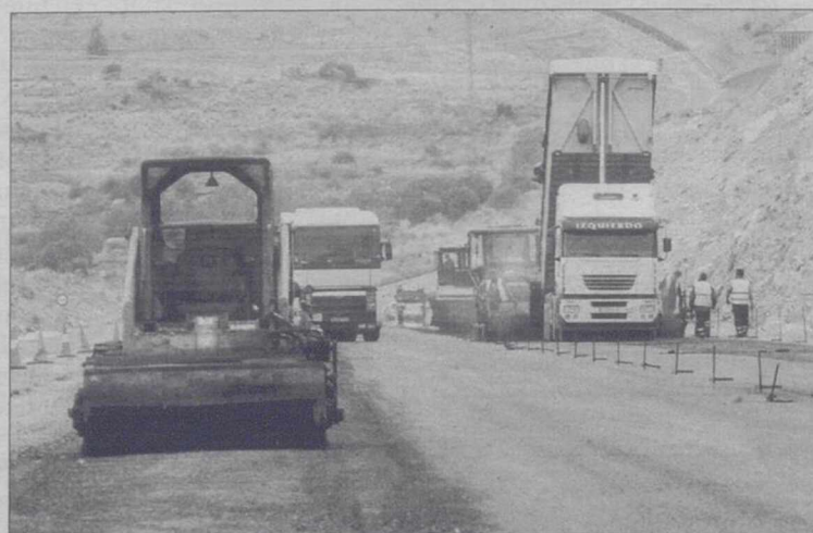
Obras en una carretera de ámbito provincial. /A.B.
