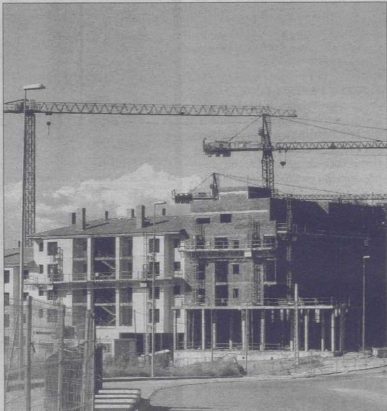
Una promoción de viviendas en construcción. / R.S.
