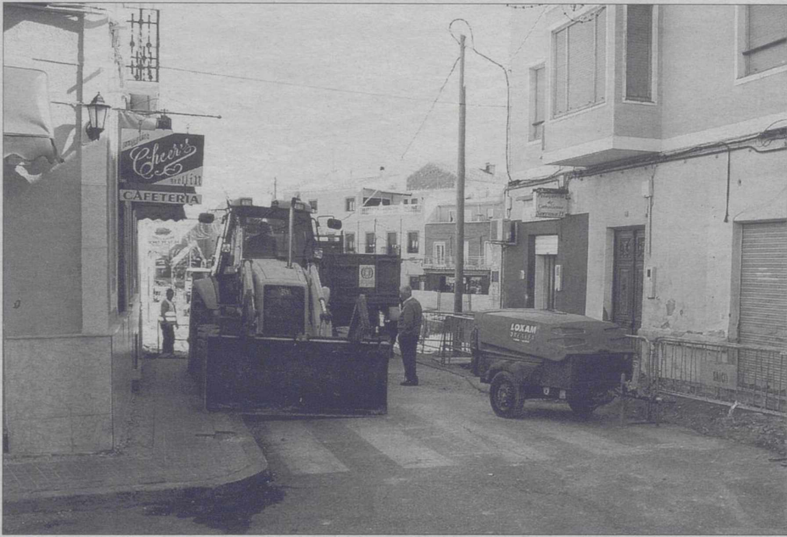
Imagen de las obras que se están realizando en la calle Pablo VI. / ÁNGEL ROMERO
