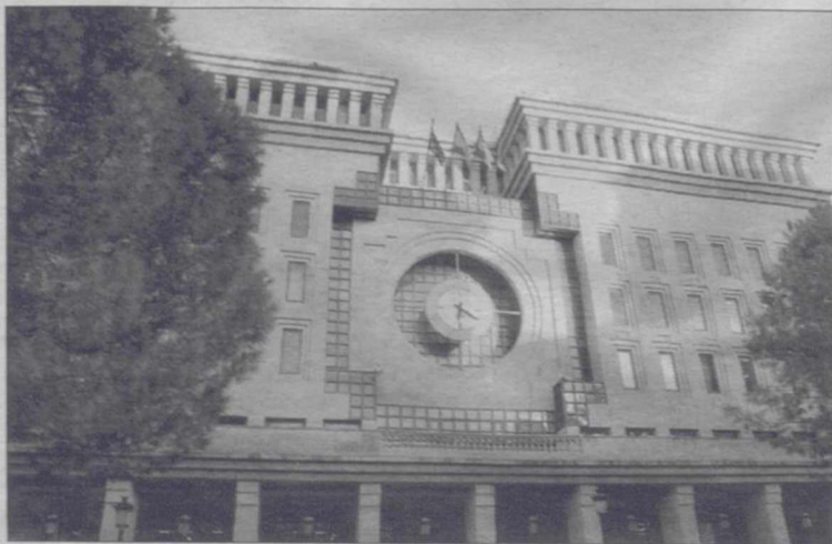
Fachada principal del Ayuntamiento de la capital. / A.P.
