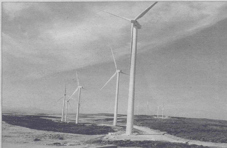
Aerogeneradores de un moderno parque eólico. / I.C.
