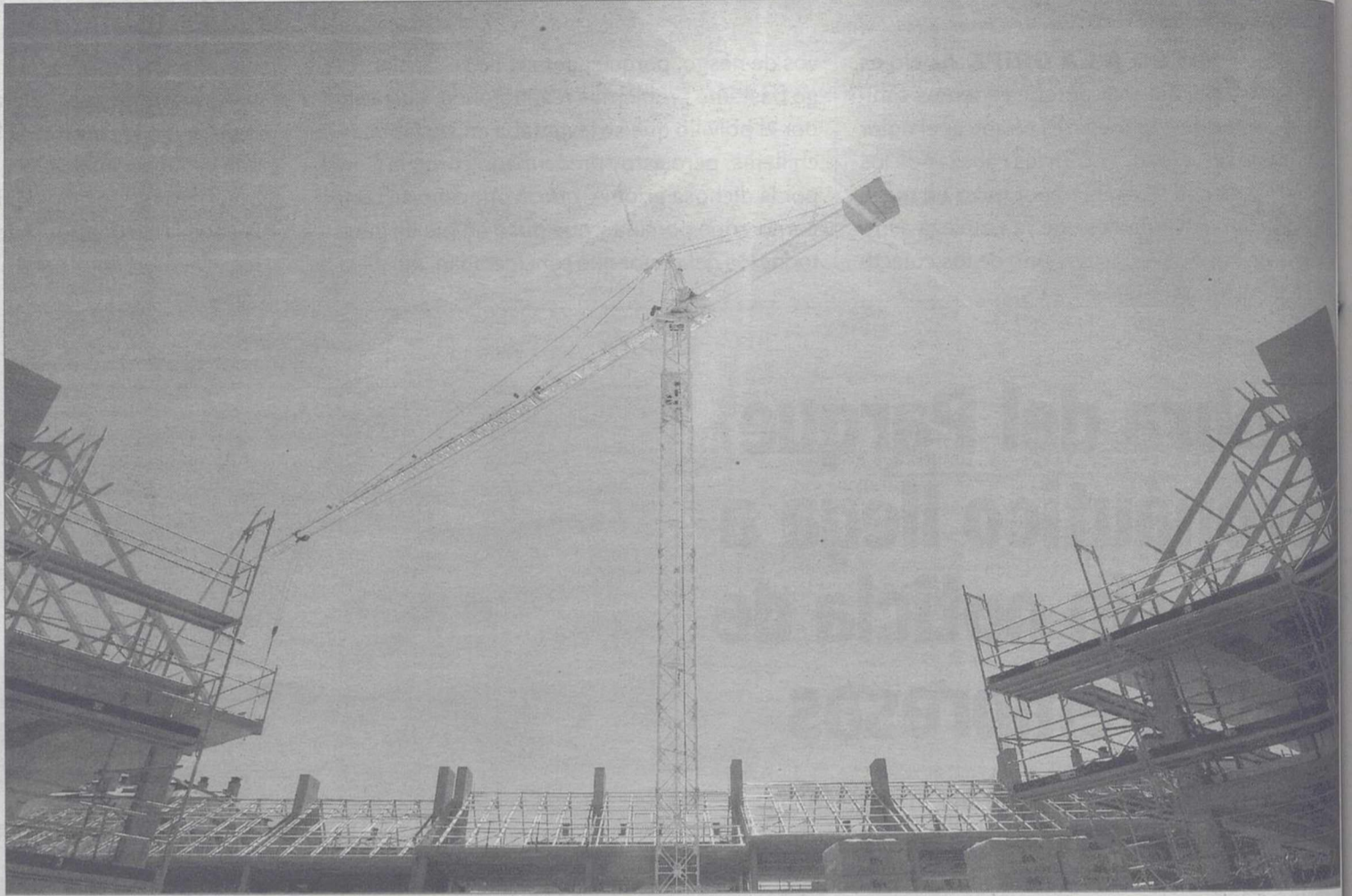
Imagen de un edificio de viviendas en proceso de construcción. / EFE
