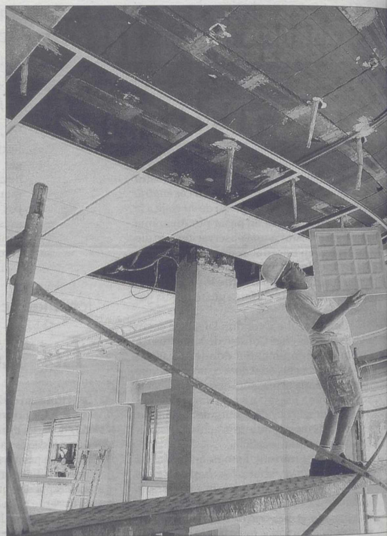
Un obrero trabaja en las mejoras que se acometen en la residencia. / A. PÉREZ
