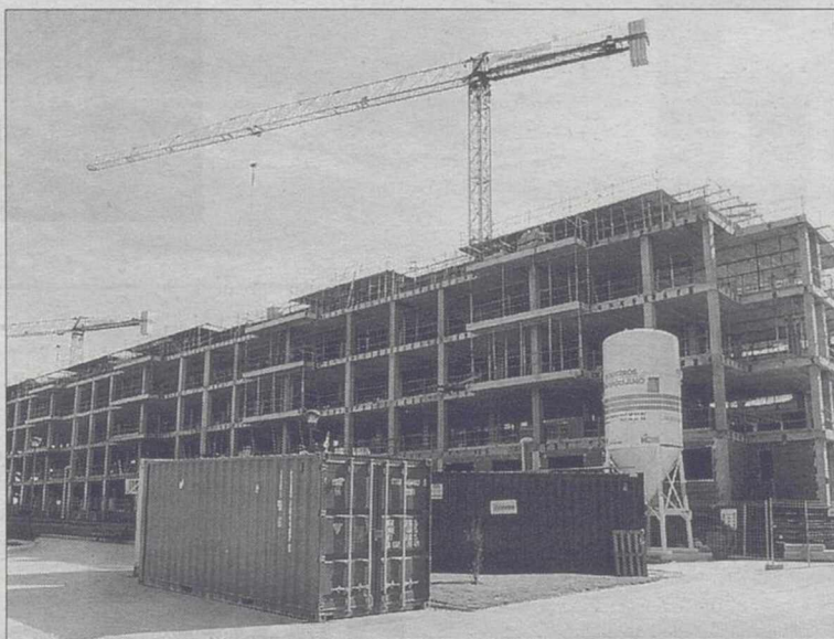
Imagen de archivo de unas viviendas en construcción. / RUBÉN SERRALLE
