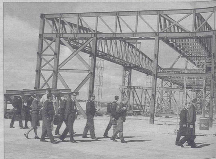
Uno de los edificios que deberá estar para el mes de octubre. / E.D.A.
