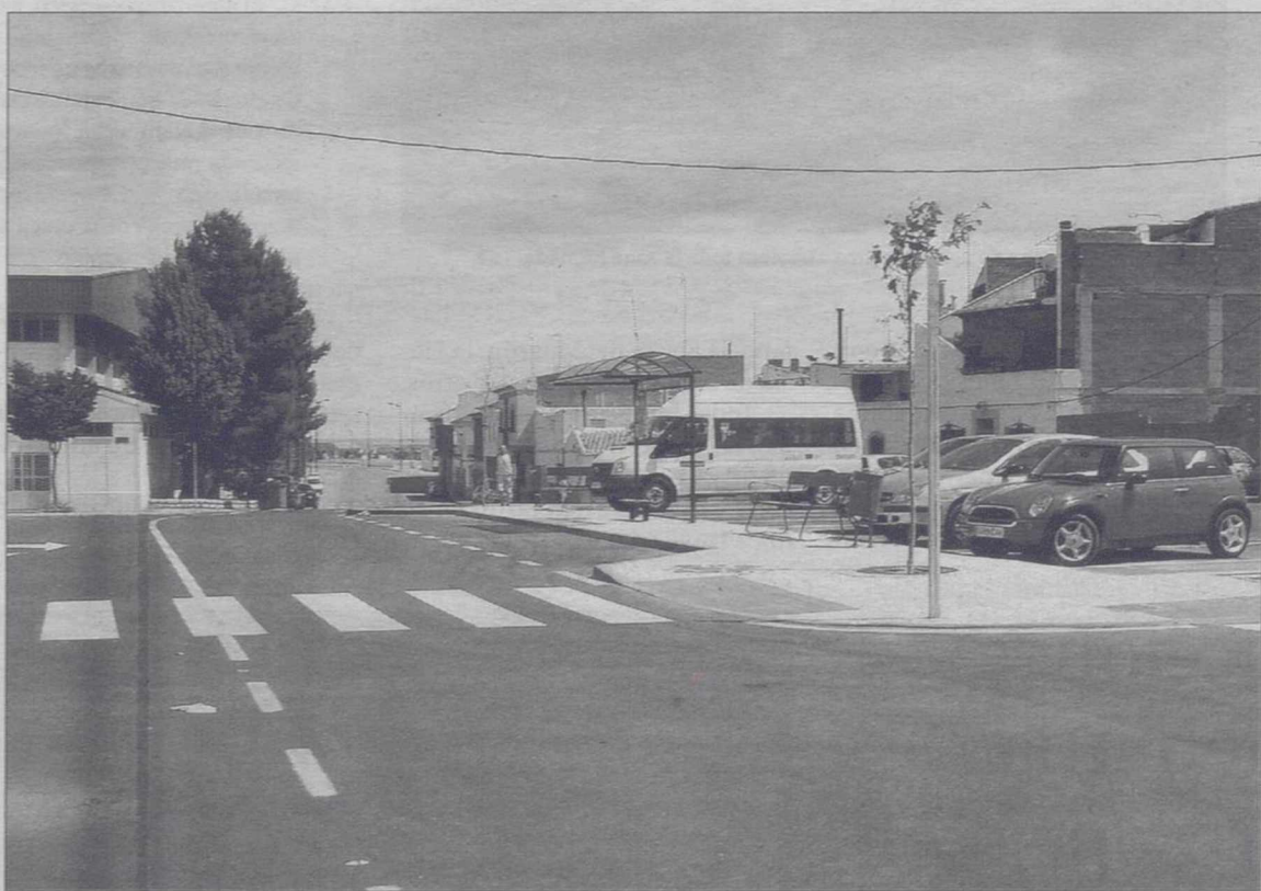
Estado en el que ha quedado, tras las obras de remodelación, la plaza pintor García Calero en la zona norte de la ciudad. / T.J.
