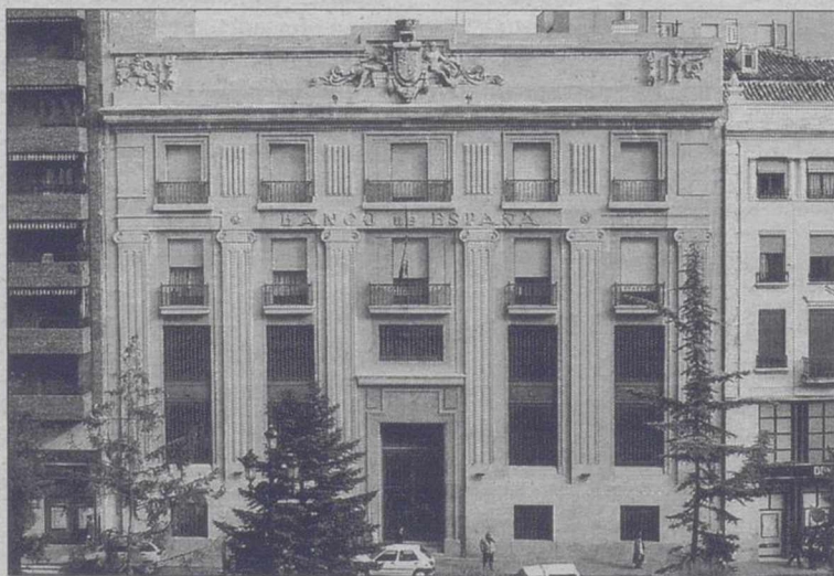
Fachada del Banco de España, inmueble que acogería el Museo del Circo. /C.L.
