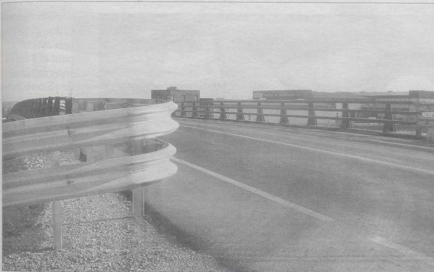
Foto del nuevo puente «sin visibilidad» que cruza la autovía A-43 y que lleva al conductor desde Villarrobledo hasta Munera. / ADEVI
