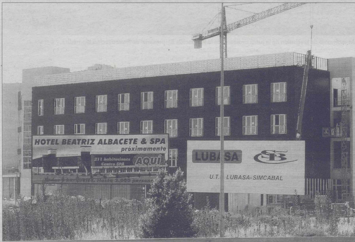
Obras del Hotel Beatriz, junto al Palacio de Congresos, un complejo que contará con spa. / REBECA SERNA
